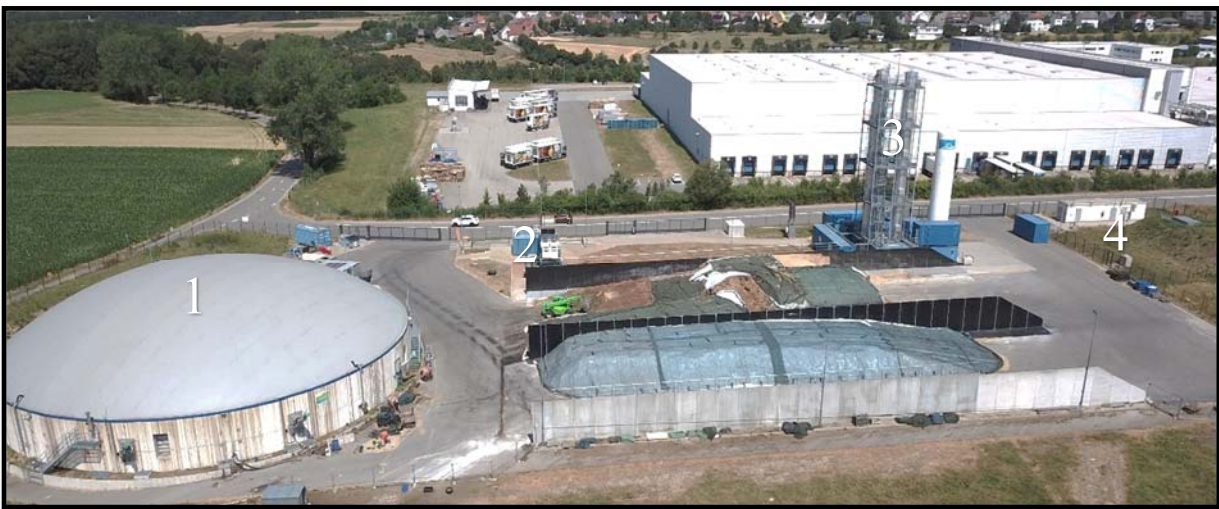
Abb. 6: Luftbild Energiepark Pirmasens-Winzeln; 1 Biogasfermenter (Mehrkammer-Reaktor mit 6000 m 3 Arbeitsvolumen), 2 Kraftwerk (580 kW BHKW), 3 zwei x 40 m 3 Druckrieselstrom-Reaktoren (Biologische Methanisierung/Power2Gas) 4 Einspeisestation in das Erdgasnetz.
